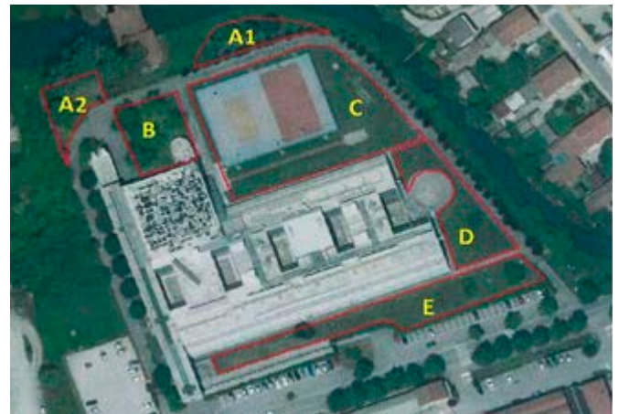
Istituto Rolando da Piazzola. Planimetria delle aree in cui sono stati eseguiti campionamenti del Top-soil del 20.07.2023
