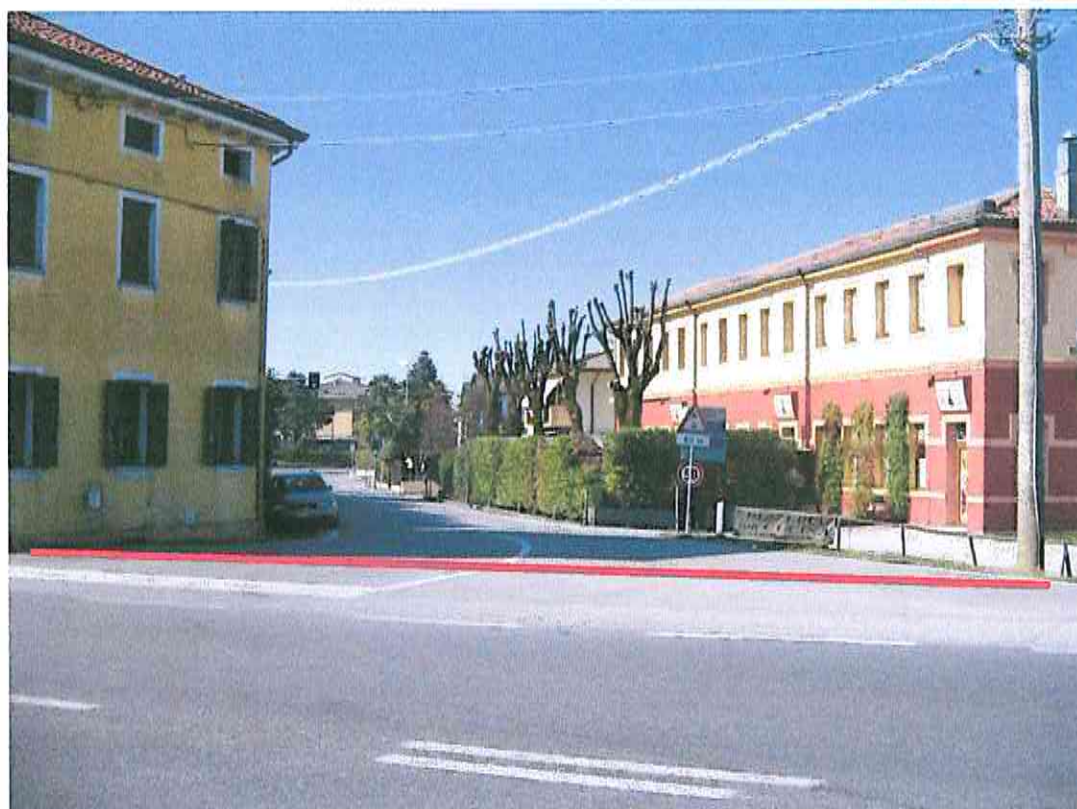
FOTO 3 - VIA PADOVA BASSANO
